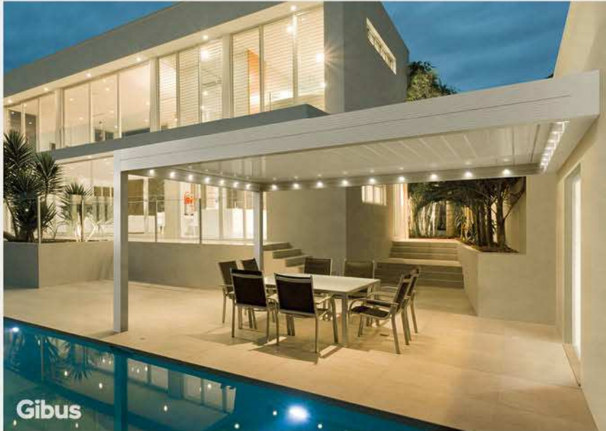
LED Spots in der Regenrinne / LED Spot intégrés dans la gouttière
