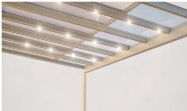
Eclairage LED par spots
